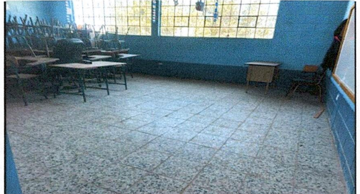
Foto 10: Aula con piso de granito.
