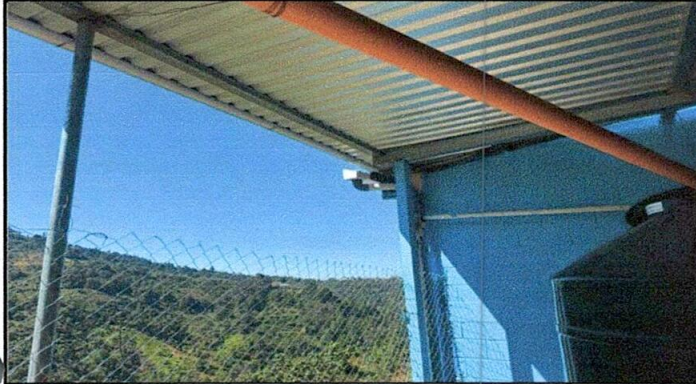
Foto 7: Canales y bajadas de agua pluvial
