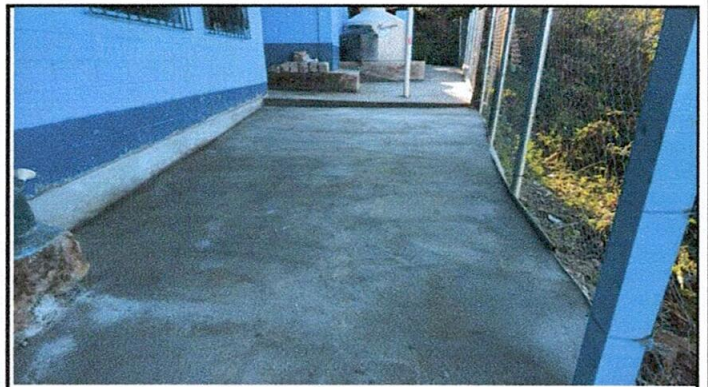
Foto 4: Losa de patio trasero e instalación de tinacos al fondo.
