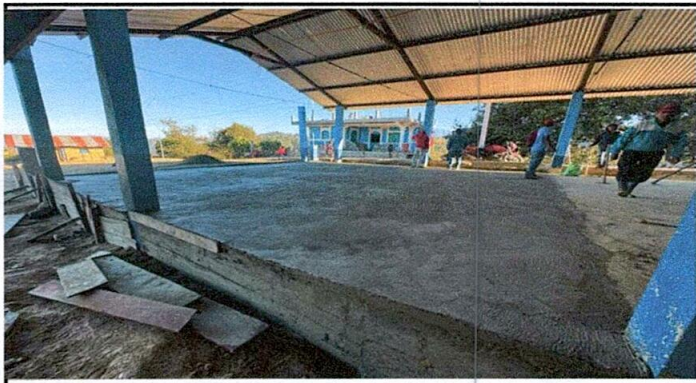
Foto 9: Losa de patio general vista desde adentro del establecimiento.
