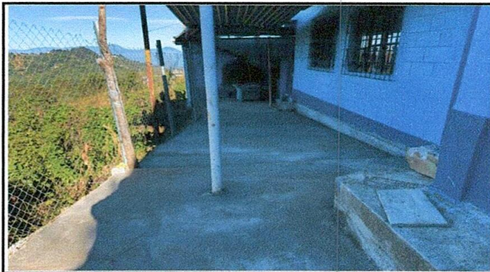
Foto 3: Losa de patio trasero y pintura de muro exterior.
