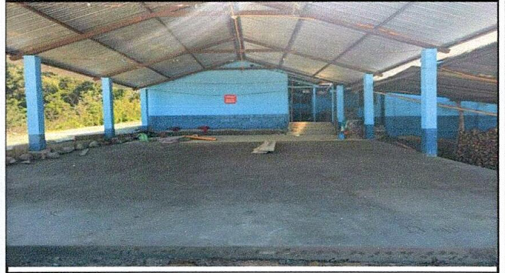
Foto 8: Losa de patio principal.
